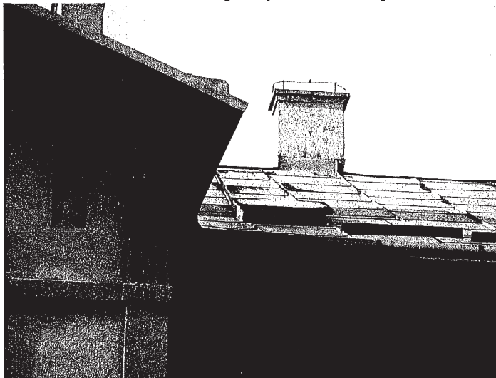
Fot. nr 9. Rdza na pokryciu dachowym.
