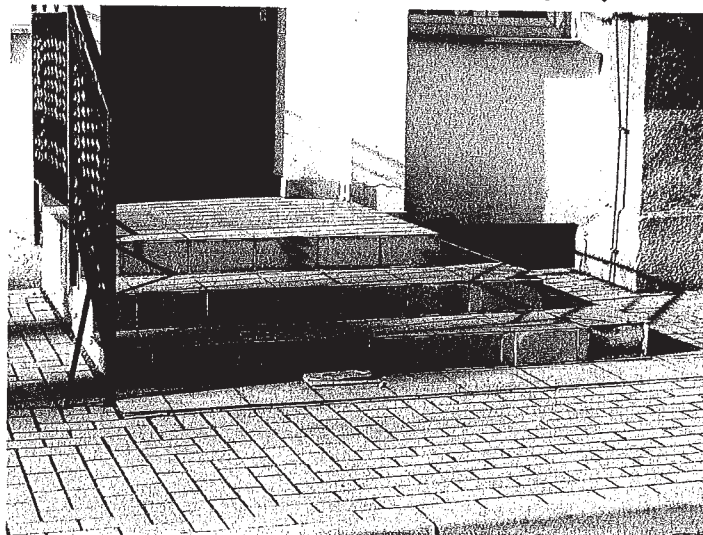
Fot. nr 5. Uszkodzenia schodów zewnętrznych.
