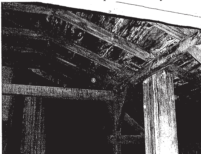
Fot. nr 12. Deskowanie połaci dachowej.
