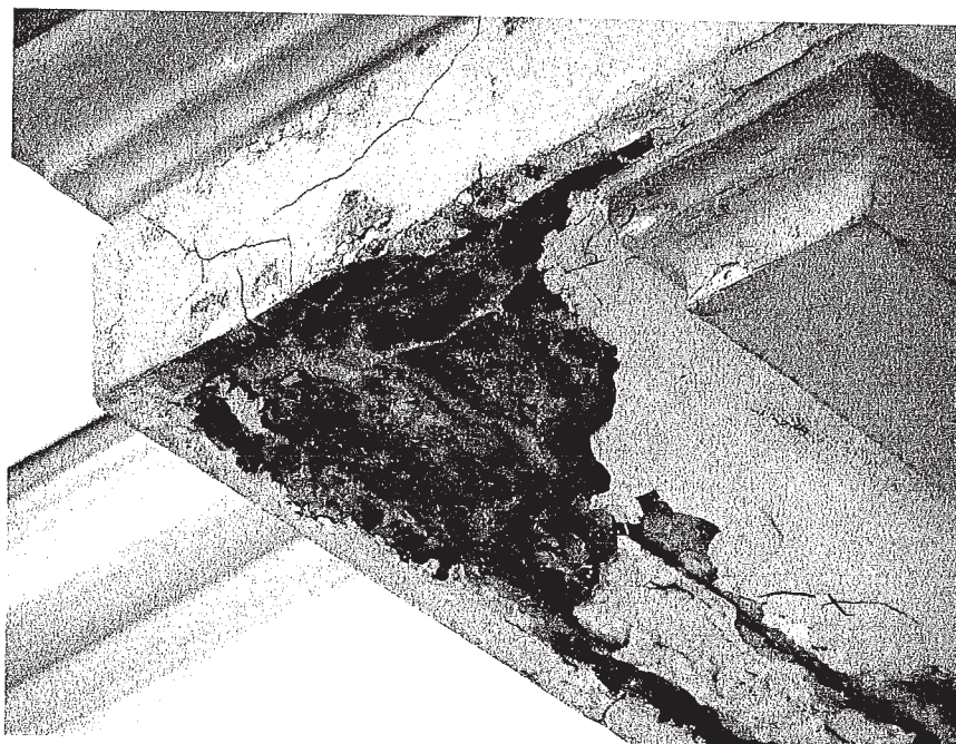
Fot. nr 2. Uszkodzenia płyty balkonu - zbliżenie.
