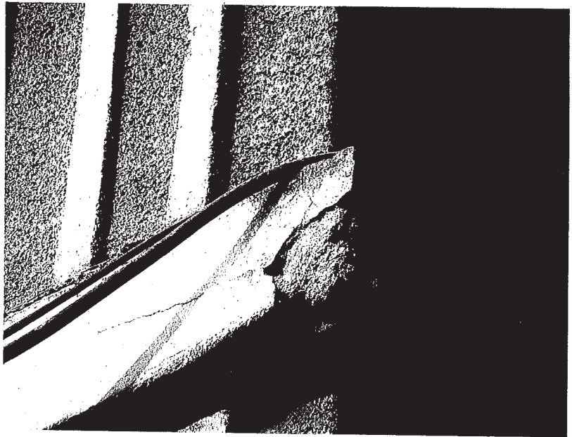
Fot. nr 1. Uszkodzenia gzymsu.
